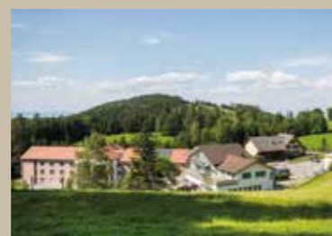
Wohnheim Bellevue, Walzenhausen
