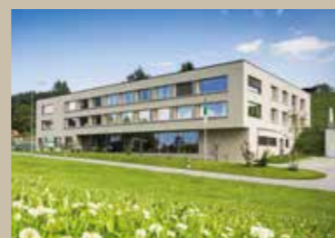
Wohnheim Krone, Walzenhausen
