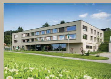
Wohnheim Krone, Walzenhausen
