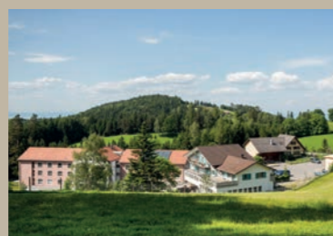
Wohnheim Bellevue, Walzenhausen
